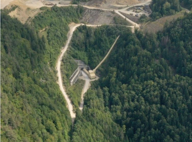
Abbildung 13: Beispiel einer Materialförderanlage (Rohrgurtförderer im Steinbruch Tschärner, Péry - La Heutte)
